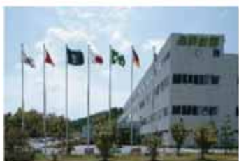
丸子電子機器工場
