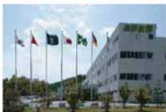
丸子電子機器工場
